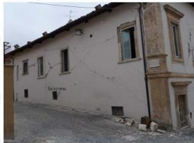
Figura 5 – a) Schema di riferimento per lesioni alle murature (Manuale AeDES) – b) Rottura della parete per effetto del taglio – Terremoto de L'Aquila
